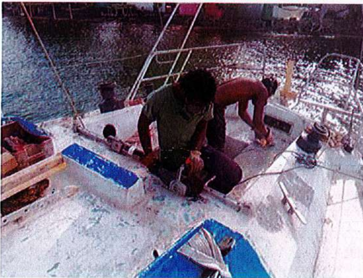
Ateliers de réhabilitation d'un navire dans le cadre du projet de découverte maritime et de chantier naval
